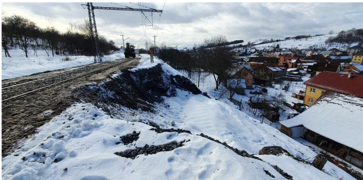
Obrázek 2 Pohled na sesuv drážního tělesa
